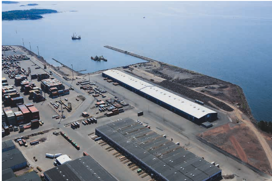
Mussalon D-alueen rakennustoissa on hyödynnetty muun muassa ruopattuja maa-aineksia sekä puhdasta betonia- ja tiiliä jätettä.
